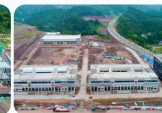
建设中的原辅材料交易中心
