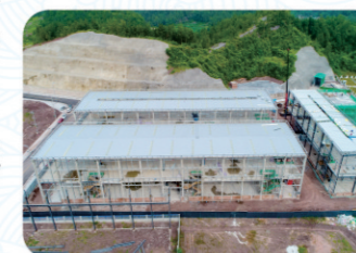
建设中的共享喷涂中心
