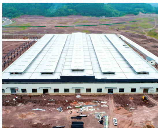
建设中的企业自建厂房
